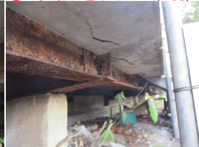
⑧床版ジャンカ コンクリート施工不良
