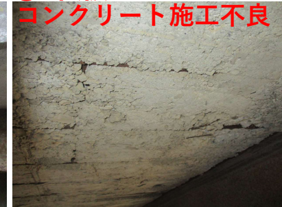
⑧床版ジャンカ コンクリート施工不良
