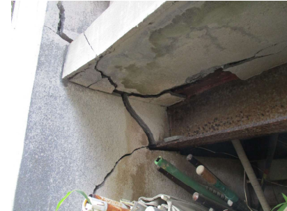
⑦床版欠損・露筋
