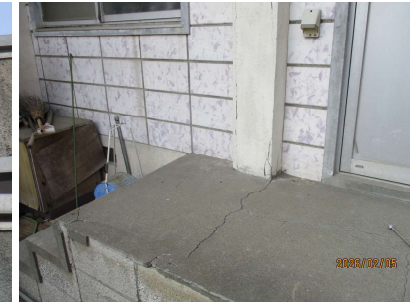
⑬柱亀裂・床亀裂
