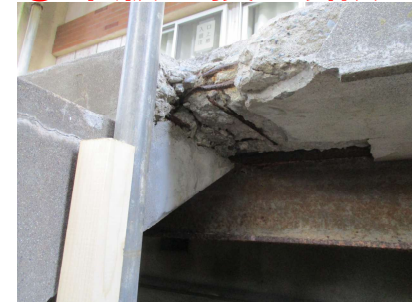
⑦床版欠損・露筋
