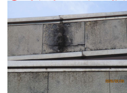
⑫外装仕上げ欠損
