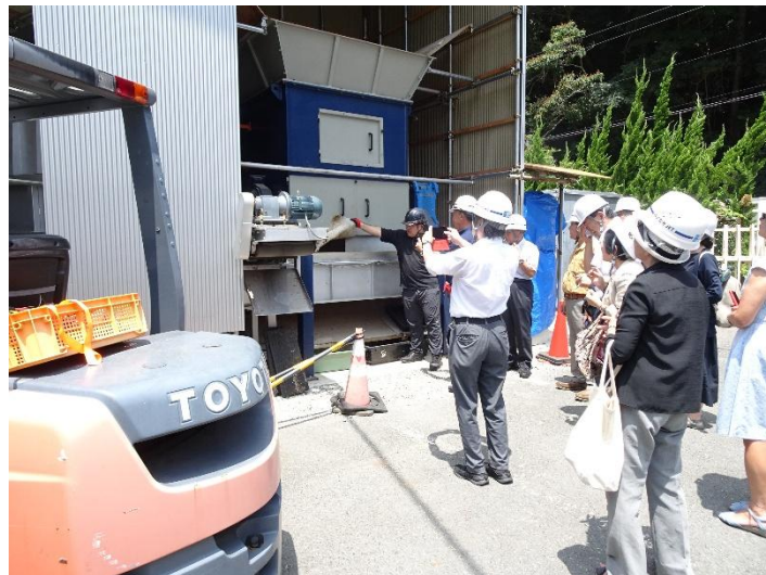
南伊豆清掃センター内・ERSの廃棄物投入口の様子
