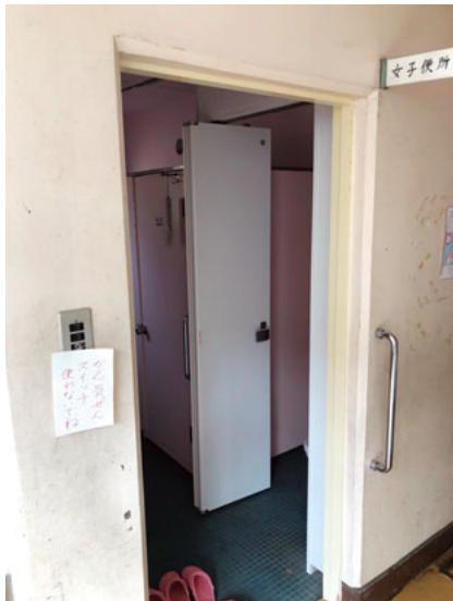
急がれるトイレの改修
