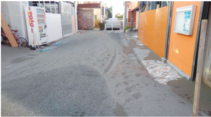
森戸海岸沿いの飛砂被害
