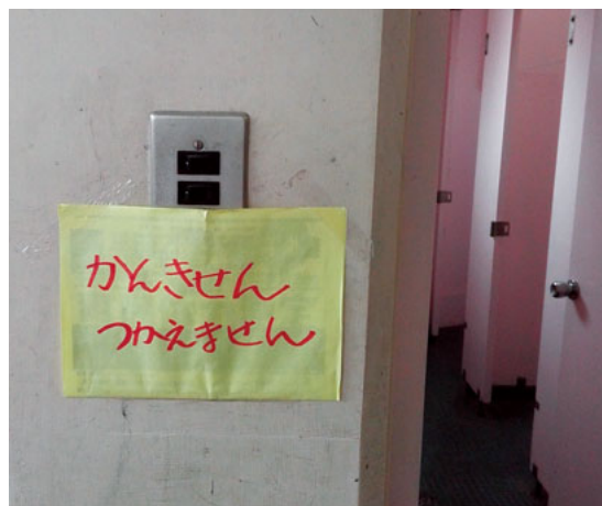
故障中のトイレ換気扇
