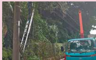
危険木伐採の様子
