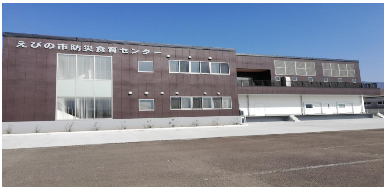
📍 えびの市防災食育センター外観
