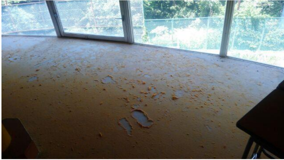
体育館2階フロアの状況
