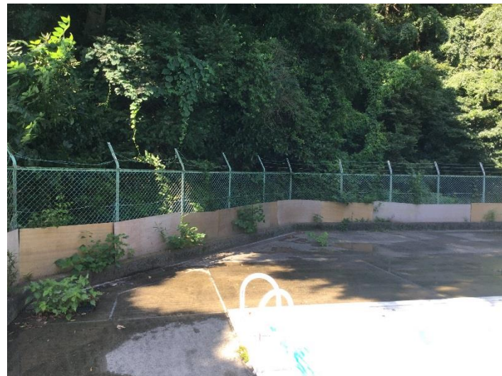
プール蛇進入除け板
