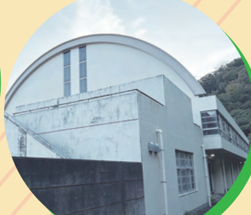
葉山中学校体育館
