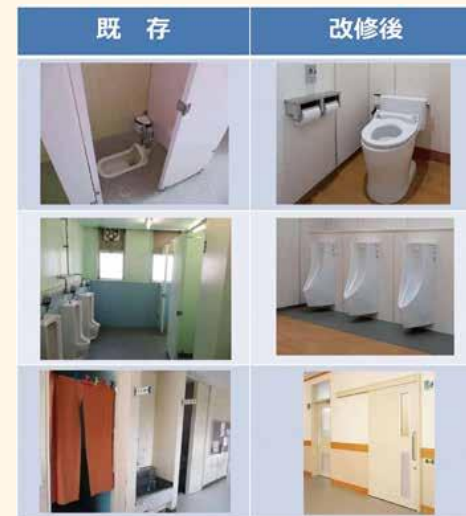
長柄小学校トイレ改修工事
