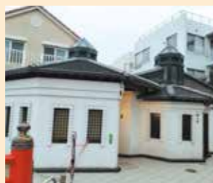
みそぎ橋公衆トイレ
