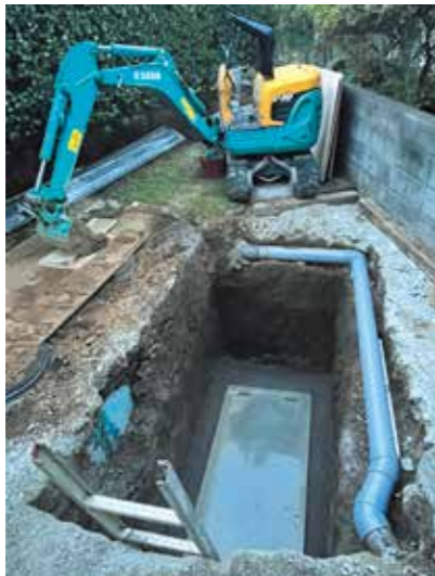
合併浄化槽への転換工事
