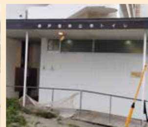
森戸海岸南公衆トイレ
