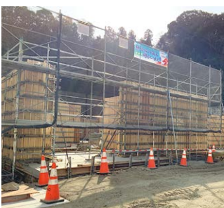
完成が遅れる 生ごみ資源化処理施設
