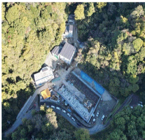
生ごみ資源化処理施設建設工事
