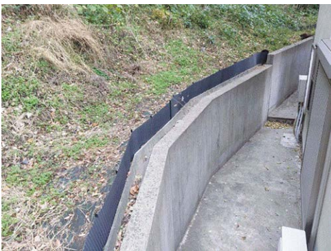
民家に設置した畔シート
