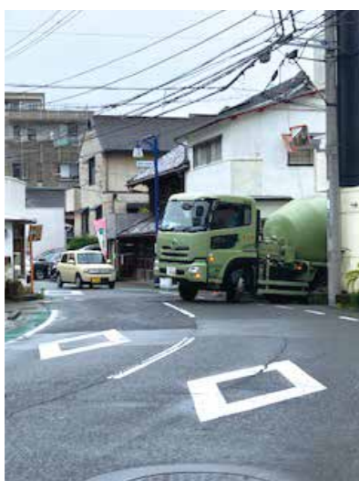
工事車両が切返してバックで進入
