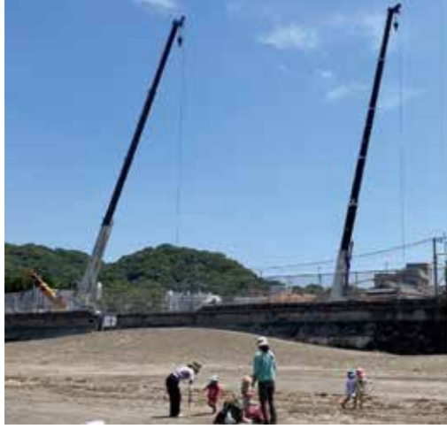
森戸海岸から見た工事現場
