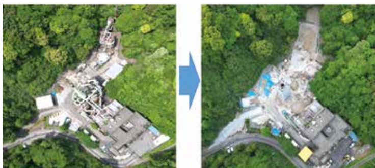
5月現在解体工事進捗状況
