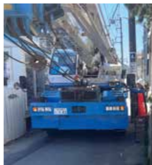
道路いっぱいの工事車両
