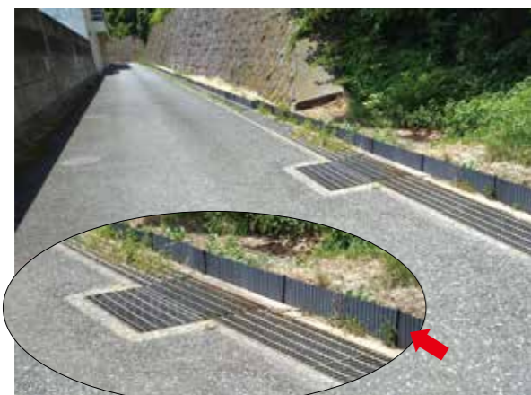
約80m続く葉山中学校に設置してあるアゼシート
