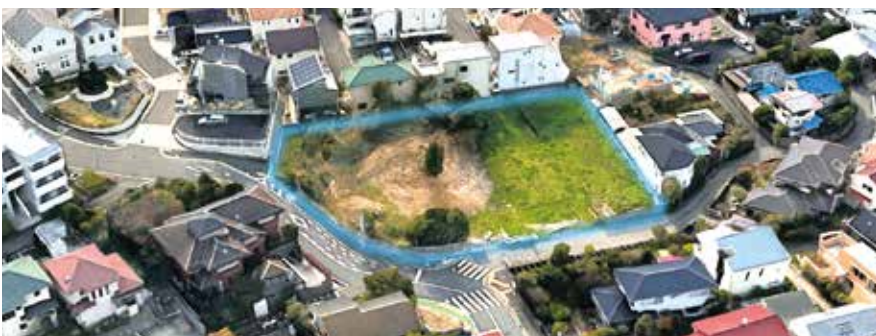
三家橋付近のマンション建設予定地
