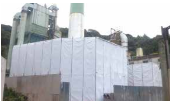
焼却施設の仮設養生
