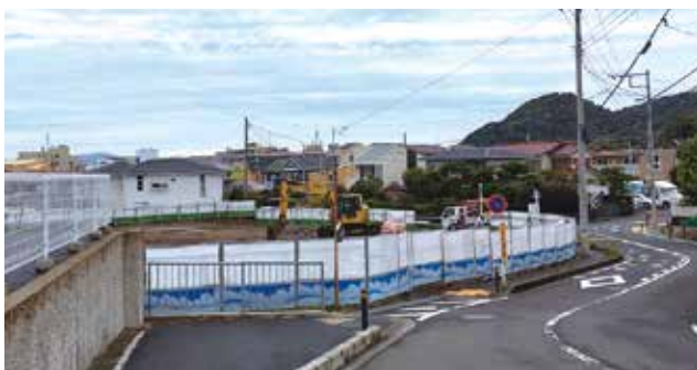
三家橋のマンション予定地
