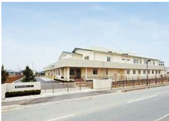
滋賀県愛荘町給食センター
