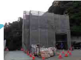
※管理棟建設工事
