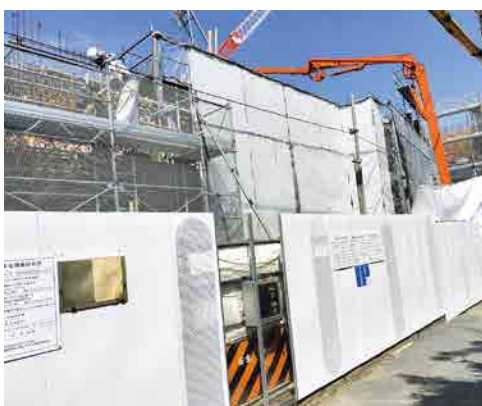
ホテル建設現場
