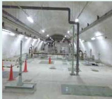
浄化センター第4系列の機械電気設備増設
