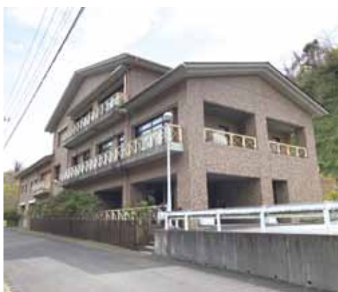
葉山町浄化センター
