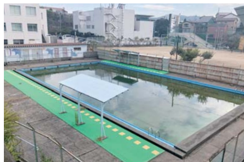
老朽化が進む小学校プール
