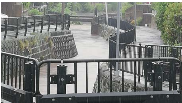
集中豪雨で増水した下山川合流地点
