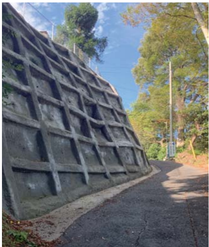
自費施行の防災工事現場
