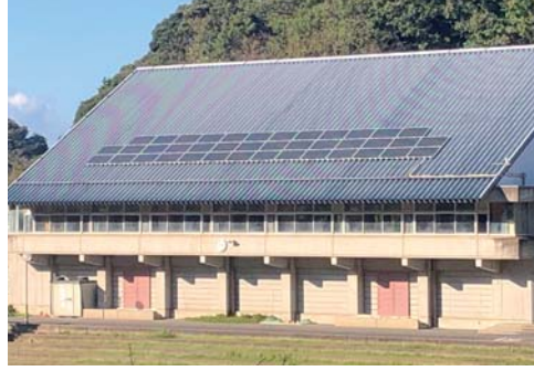
南郷中学校の太陽光パネル
