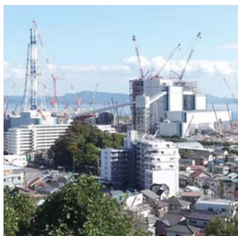
建設中の横須賀石炭火力発電所
