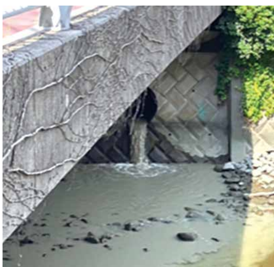
開発工事現場から放流された白濁水
