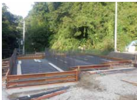
建設中のびん類ストックヤード
