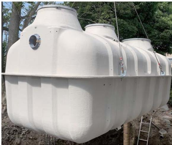
合併処理浄化槽
