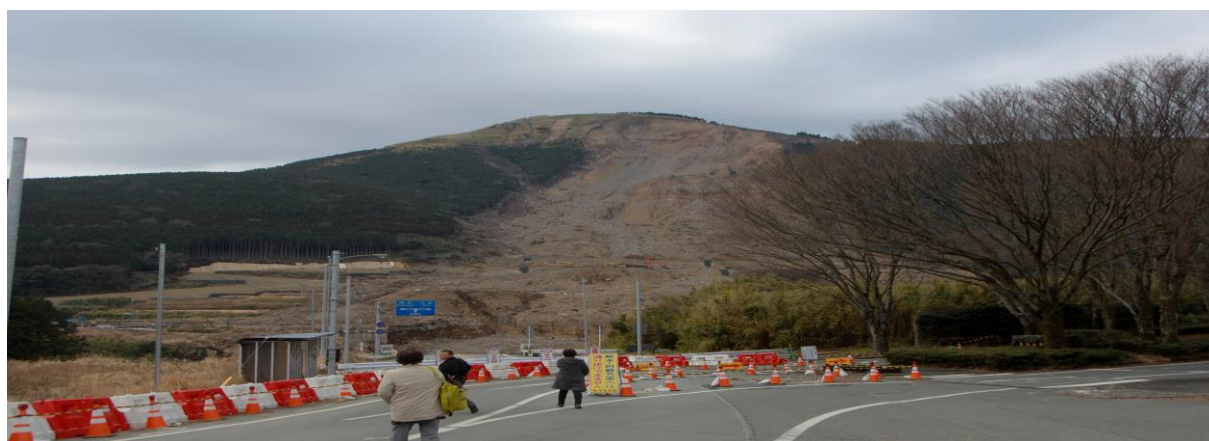
1月18日南阿蘇村東海大農学部前にて 阿蘇大橋陥落現場57号線不通
