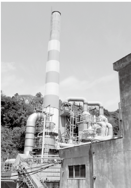
廃炉が決まったごみ焼却炉
