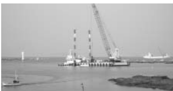
真名瀬漁港沖消波堤浚渫工事
