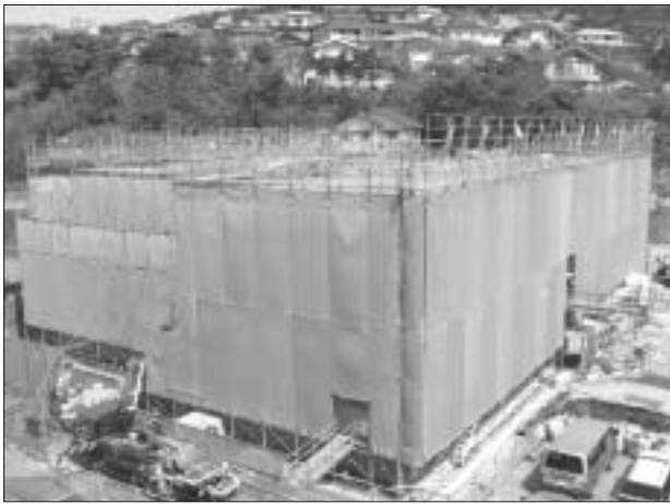
本年10月開設予定の (仮称) 保育園・教育総合センター 複合施設建設現場
