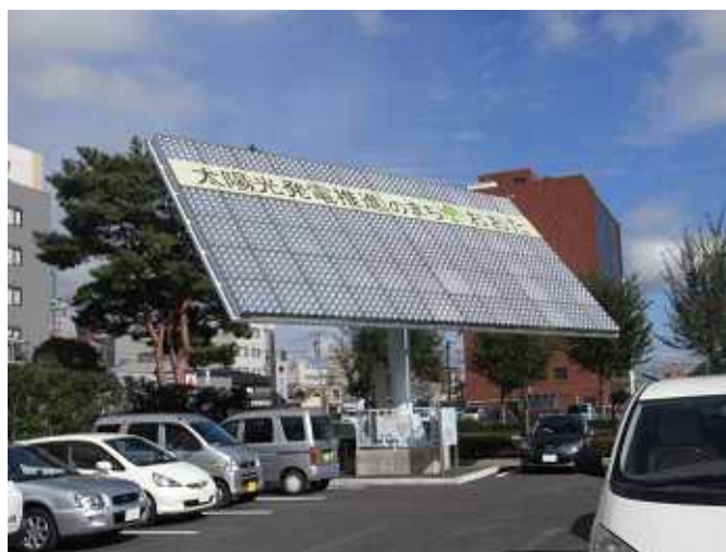
集光追尾型太陽光発電システム（市役所）
