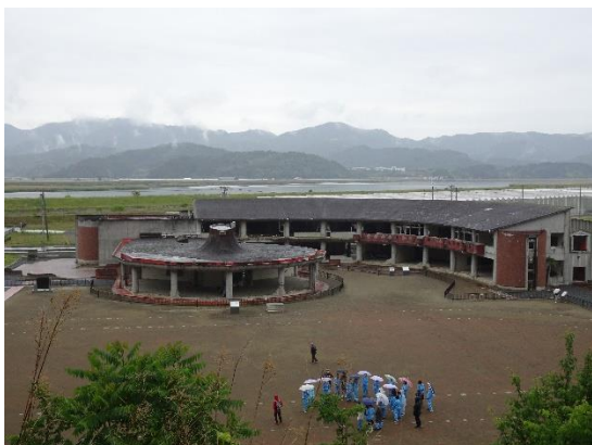
震災遺構大川小学校
