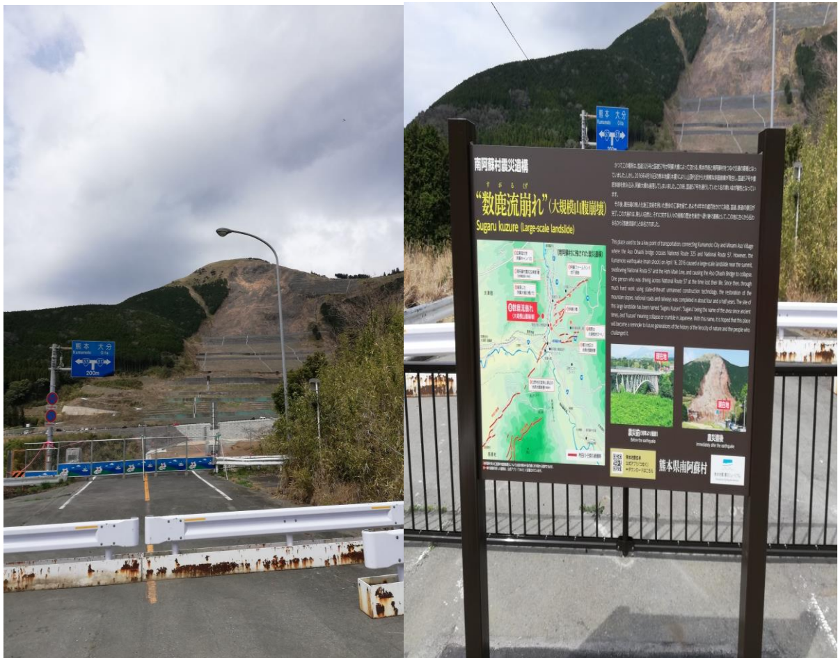
旧阿蘇大橋の崩落現場。案内板が設置されていた。東海大は閉鎖されている。
