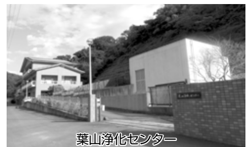
し尿投入施設
