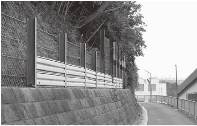
葉山小学校裏の急傾斜地
