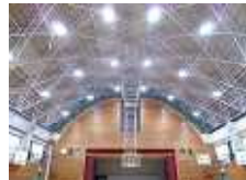
▲ 体育館耐震工事
