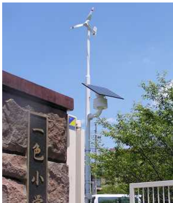
一色小学校の風力・太陽光発電装置
