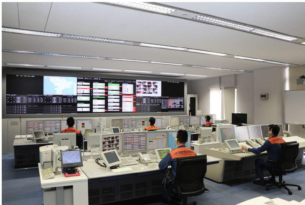
横須賀市・葉山町消防指令センター
