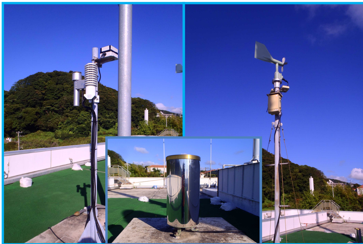
消防庁舎屋上の気象情報収集装置
