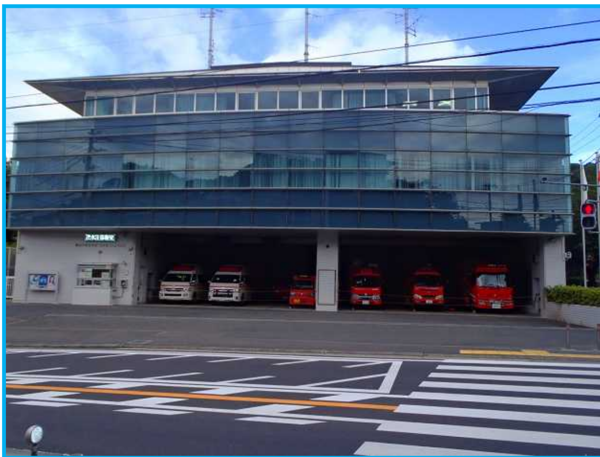
葉山町消防本部庁舎
