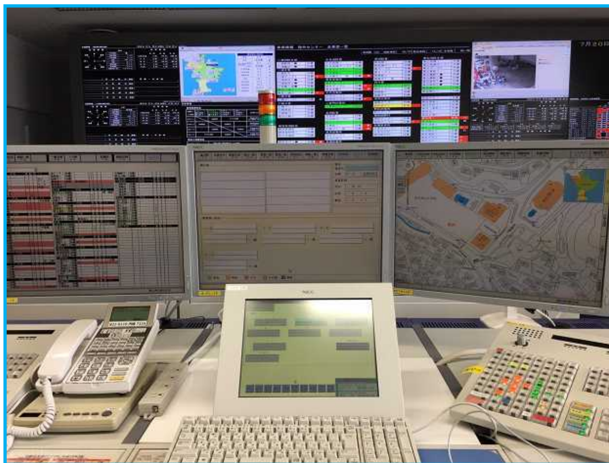
横須賀市・三浦市・葉山町消防指令センター
