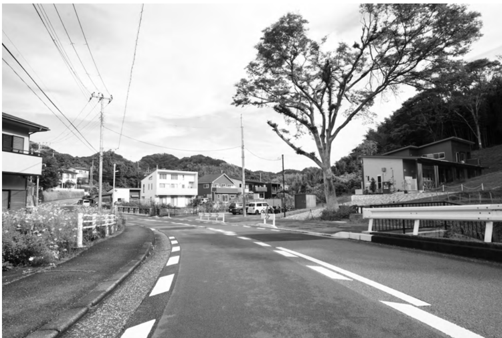
町道（水源地橋周辺）
