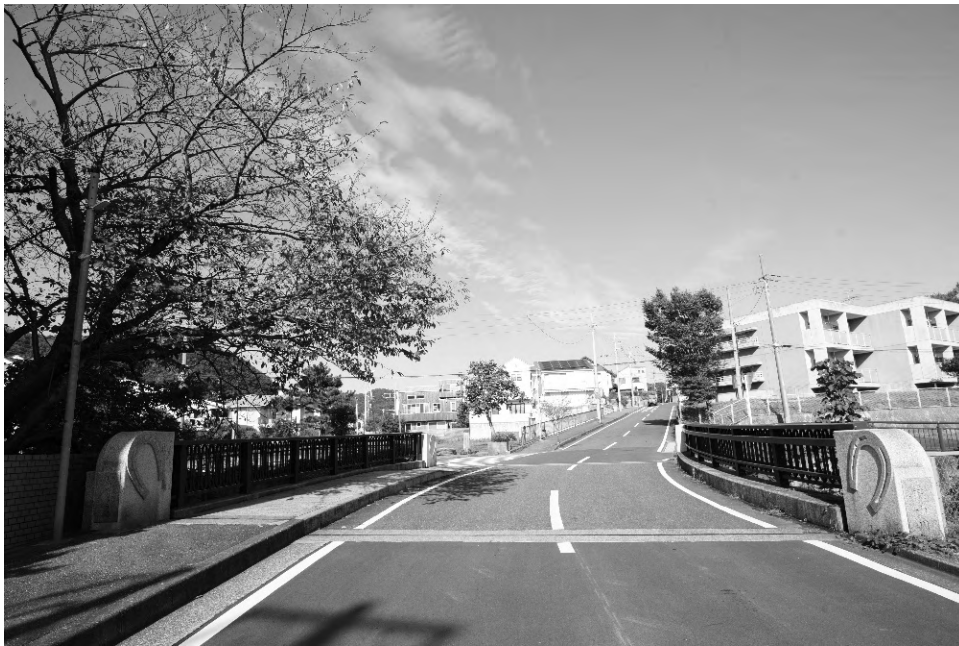
しゅめりょう橋（下山口地区）
