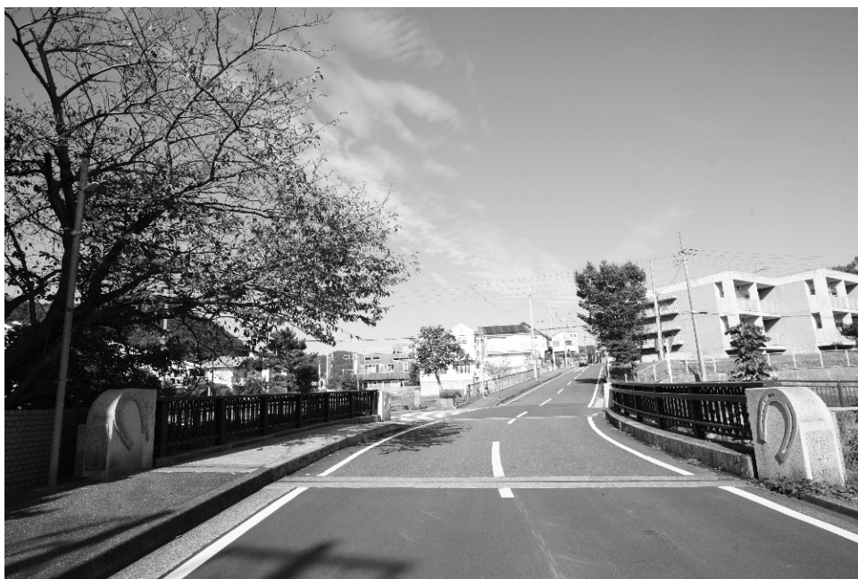
しゅめりょう橋（下山口地区）
