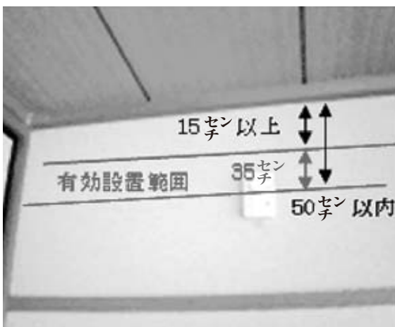
▶取付例 壁に取り付けた場合 （警報器の中心が天井から15センチ〜50センチ以内の位置に設置します）
