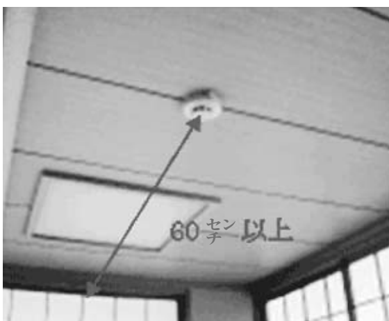
▶取付例 天井に取り付けた場合 （壁・梁から60センチ、エアコン等空調機器の吹き出し口から1メートル50センチ以上離して設置します。）
