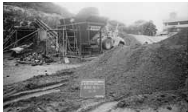
▼葉山小学校グランド整備工事
