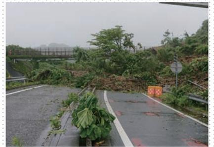
逗子ICのり面の崩落(写真:東日本高速道路(株)より提供)
