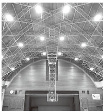
▲工事した後の天井
