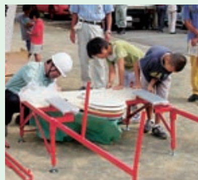
▲仮設トイレの組み立てを手伝った小学生。「これ本当にトイレになるの?」ちゃんと壁やドアも付いた洋式トイレができました。下水のマンホールの上に設置します。
