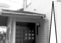
エアコン4基 一色岡会館
