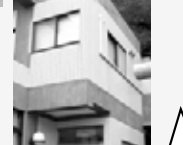
エアコン4基 真名瀬会館
