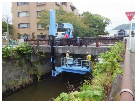
しゅめりょう橋
