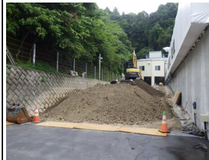
〔スロープⅠ施工前〕
