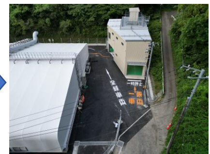
〔C工区アスファルト舗装完了〕
