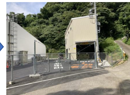
〔入場口施工完了〕
