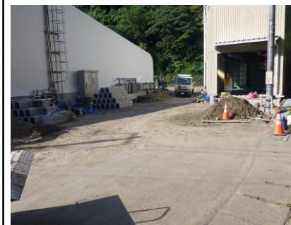
〔入場口施工前〕
