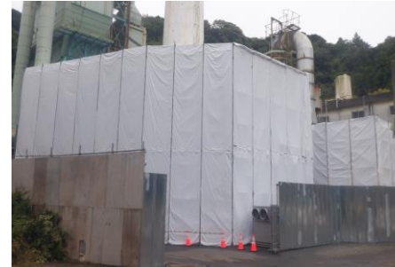
〔足場設置状況〕
