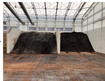
〔生ごみ資源化処理施設発酵状況〕
