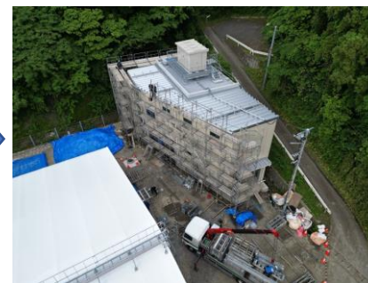
〔資源物棟外部足場解体状況〕
