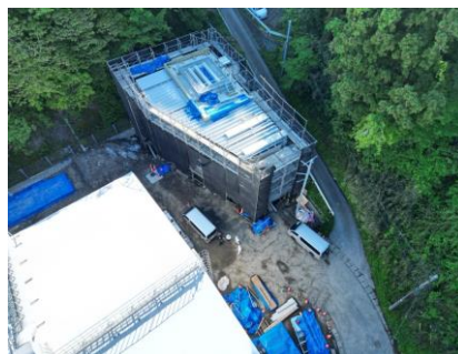
〔資源物棟外壁状況〕
