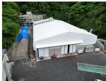
〔生ごみ資源化処理施設外観状況〕
