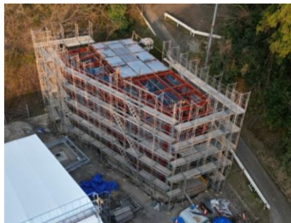
〔資源物棟鉄骨状況〕
