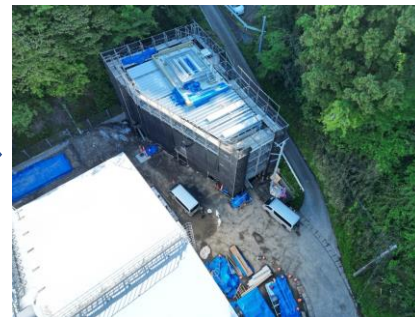
〔資源物棟屋根敷設状況〕
