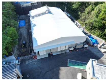
〔生ごみ資源化処理施設周辺設備完了〕
