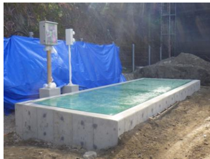
〔ごみ計量機機器据付完了〕
