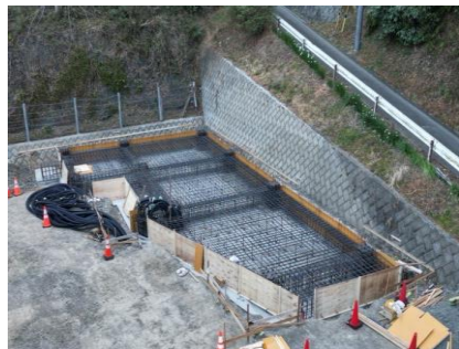
〔資源物棟耐圧版施工状況〕
