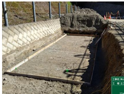
〔ごみ計量機機器施工前〕
