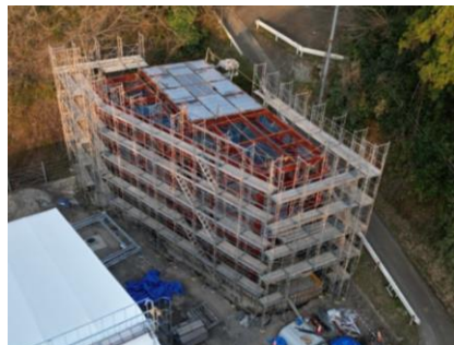
〔資源物棟鉄骨状況〕
