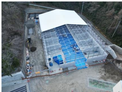
〔生ごみ資源化処理施設tent状況〕
