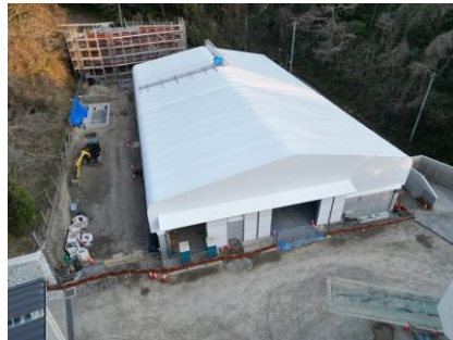
〔生ごみ資源化処理施設tent完了〕
