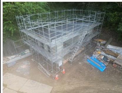
〔小物類SY外部足場解体前〕
