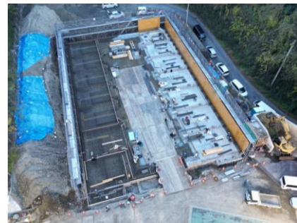
〔生ごみ資源化処理施設配筋状況〕
