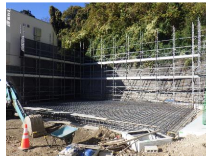
〔植木剪定枝SY耐圧版配筋完了〕
