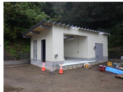
〔小物類SY外部足場解体完了〕
