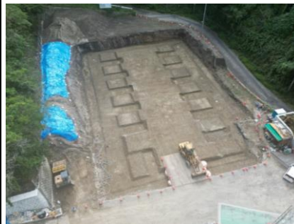
〔生ごみ資源化処理施設配筋前〕
