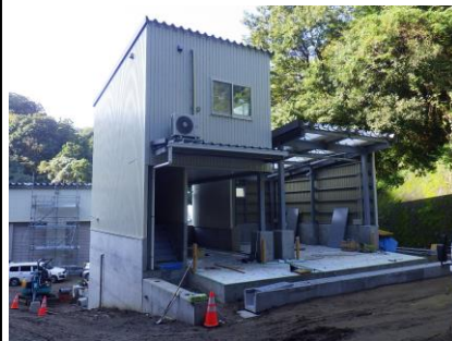
〔休憩棟・車庫棟足場解体完了〕
