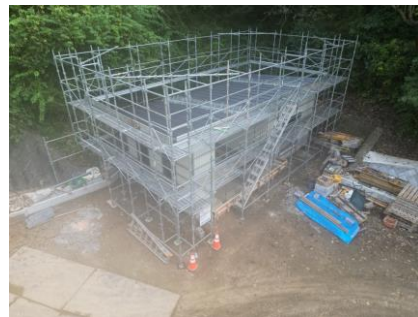
〔小物類SY外壁張り状況〕
