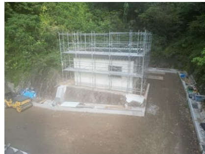
〔資材倉庫外壁張り状況〕
