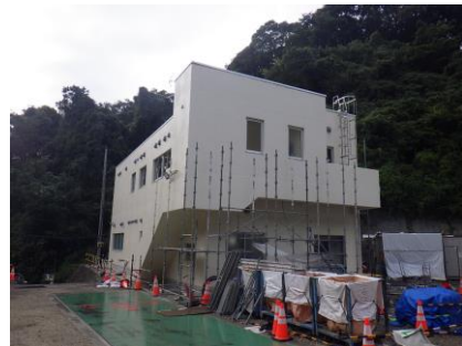
〔管理棟外壁塗装完了〕
