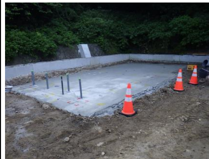
〔小物類SY施工前〕
